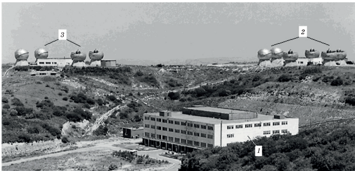
Рис. 2. Оптико-электронный комплекс “Окно” на позиции. 1 – командно-вычислительный центр, 2 – система обнаружения, 3 – система сбора информации.
